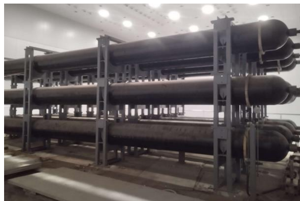
Рис. 3. Внешний вид комплекта баллонов высокого давления СВС
