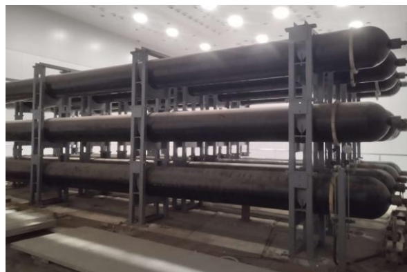
Рис. 3. Внешний вид комплекта баллонов высокого давления СВС
