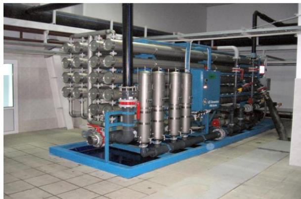
Рис. 3. Классическая установка обратного осмоса первого типа
