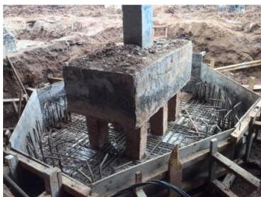
Рис. 1. Усиление фундаментов буройнъекционными сваями.
