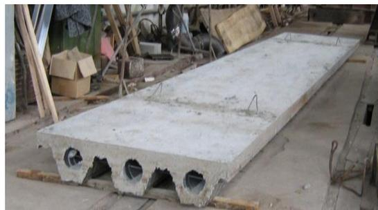
Рис. 1. Пустотноребристая плита, пролетом 6 м с внешним армированием из профнастила ТП-128 и стержневой арматурой в растянутой зоне
