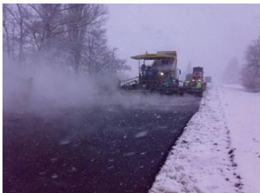
Рис. 1. Устройство асфальтобетонных слоёв при минусовых температурах воздуха
