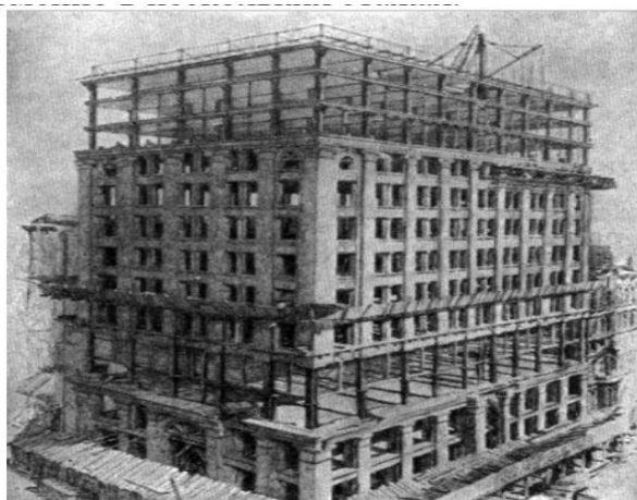
Рис. 2. Каркас из двутавровых стальных балок
