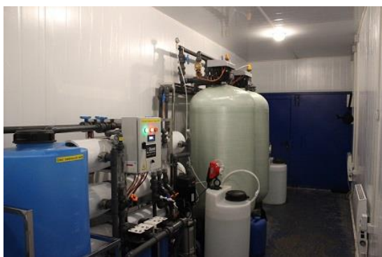
Рис. 2. Система очистки технической воды
