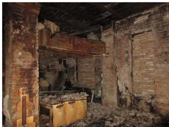
Рис. 1. Повреждения строительных конструкций здания, полученные в результате артобстрела и последующего пожара, в п. Родаково по адресу: кв. Ленина, дом 156
