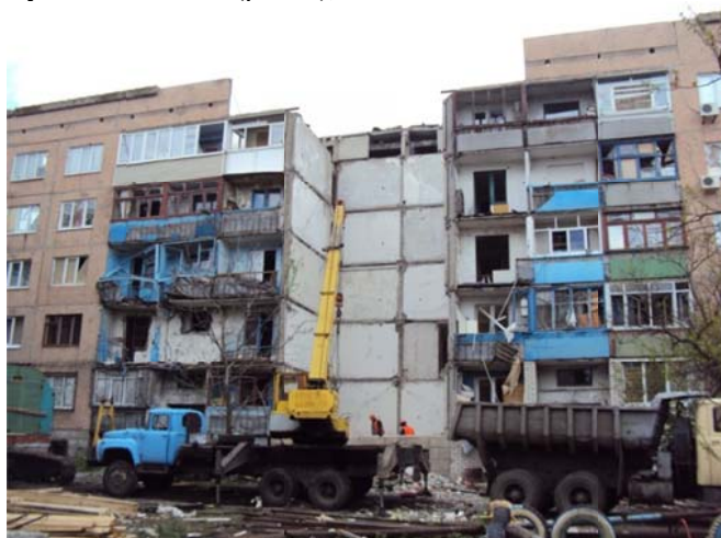
Рис. 5. Разборка разрушенной части здания
