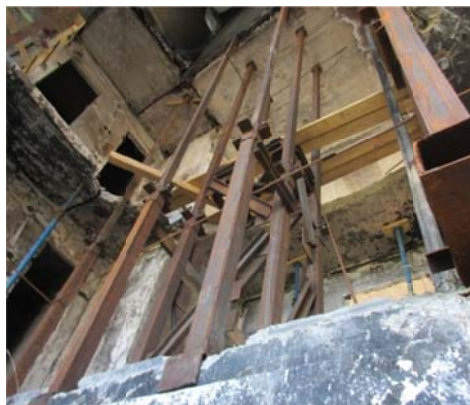
Рис. 3. Укрепление временными конструкциями плит перекрытия
