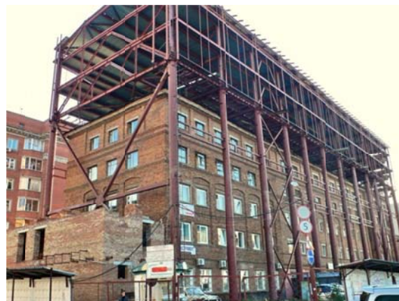
Рис. 4. Реконструкция зданий с уширением корпуса и надстройкой
