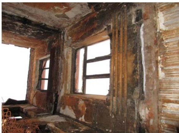
Рис. 1. Повреждения строительных конструкций здания, полученные в результате артобстрела и последующего пожара, в п. Родаково по адресу: кв. Ленина, дом 156
