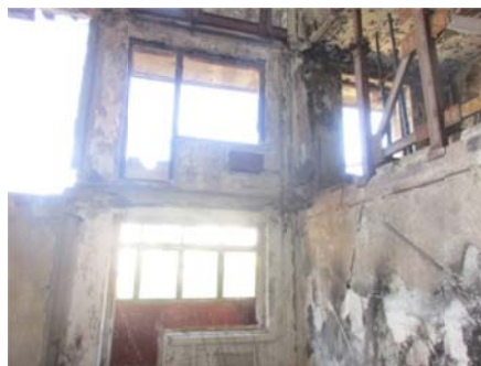
Рис. 3. Укрепление временными конструкциями плит перекрытия
