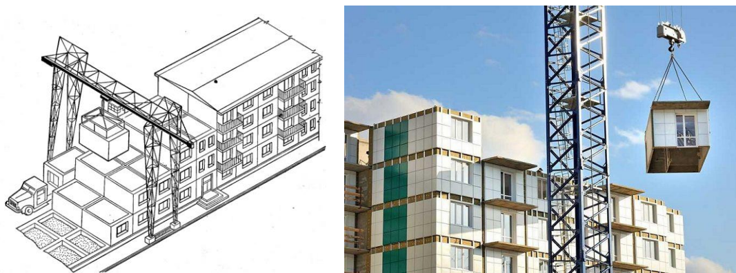
Рис. 3. Монтаж жилого дома из объемных блоков
