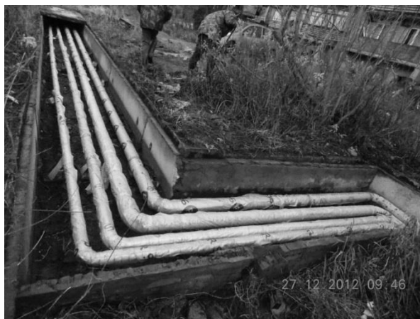
Рис. 1. Общий вид канальной тепловой сети
