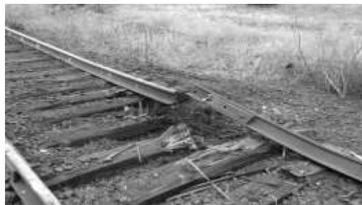
Рис.2. Разрушение рельсов и деревянных шпал, разрушение стыков, образование воронок в земляном полотне
