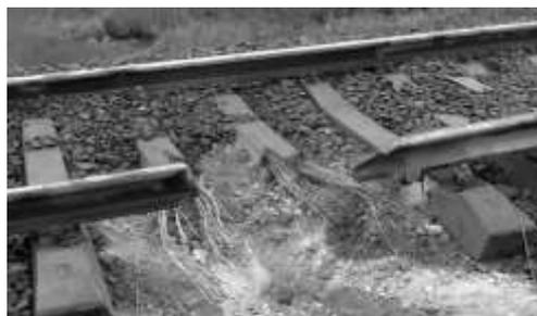
Рис.1. Разрыв рельсов и разрушение железобетонных шпал и верхнего строения пути
