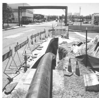
Рис. 6. Открытый и закрытый способы восстановления трубопровода
