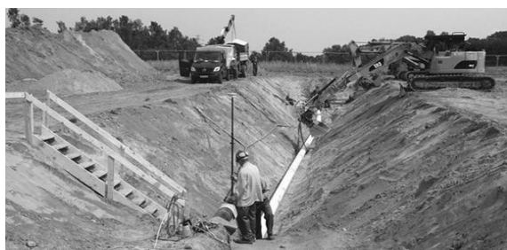
Рис.8. Замена трубопровода открытым способом строительства
