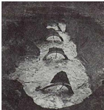
Рис. 1. Коррозионное разрушение канализационных труб газово-биогенной эксплуатационной средой
